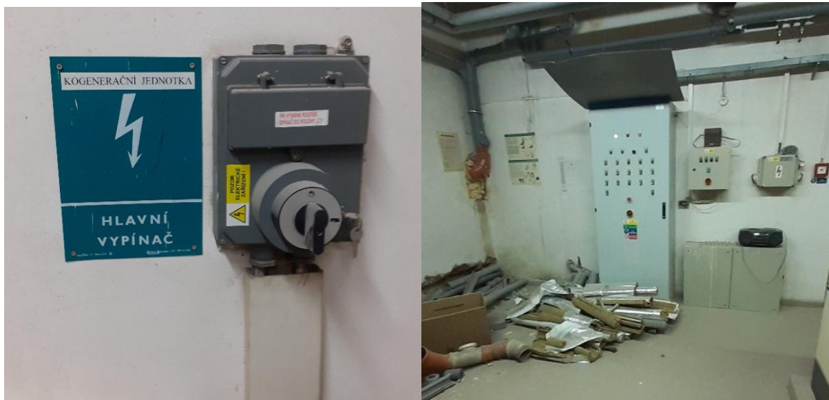
Stávající trojpólový vypínač demontovat
