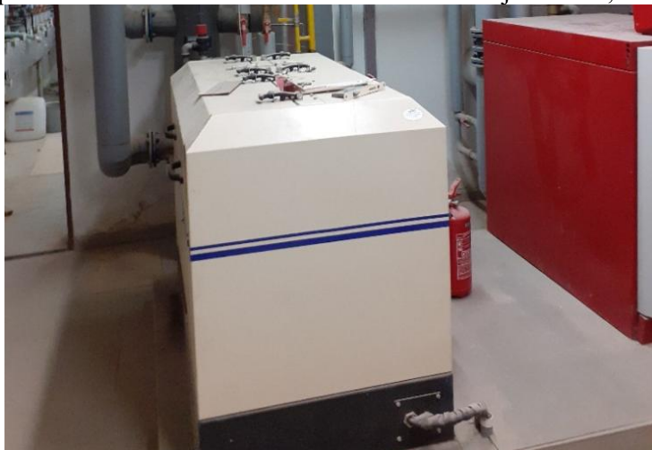
Pohled na stávající kogenerační jednotku vč. připojení
